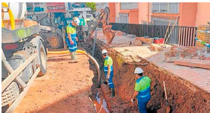
Operarios de Linaqua trabajan para rehabilitar el suministro de agua en Senda de la Moza. IDEAL
