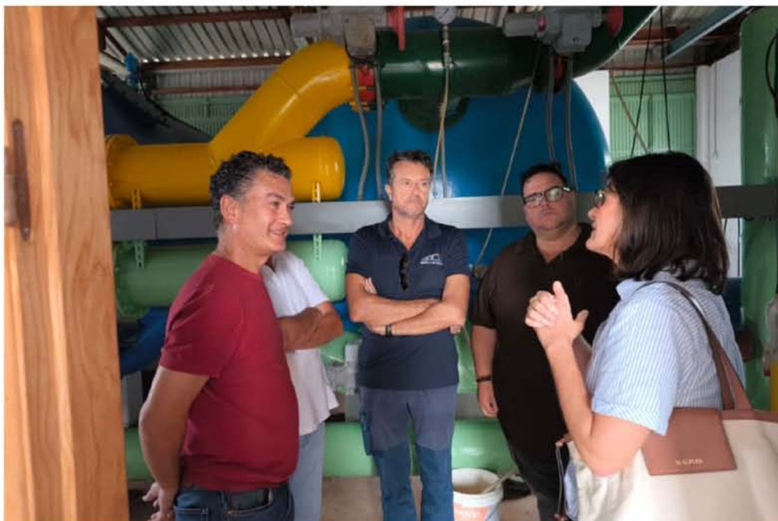
Visita a la balsa de acumulación de agua de la Contraviesa para comprobar la situación del sistema de abastecimiento | Foto: Gabinete
